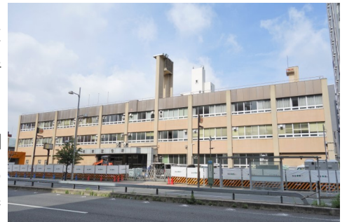
2021年6月着工時 もと城東区役所
