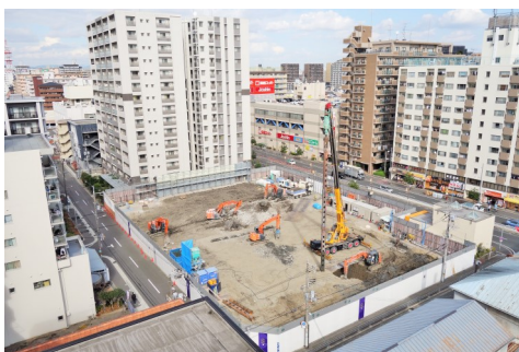
2021年11月 既存杭引き抜き
