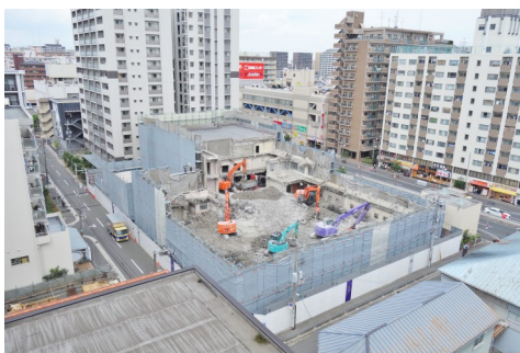
2021年7月 本庁舎建屋解体
