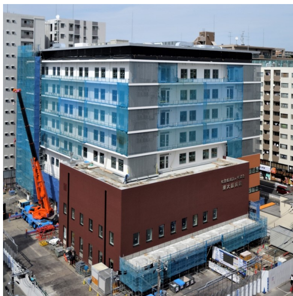
新病院 南西方向より
