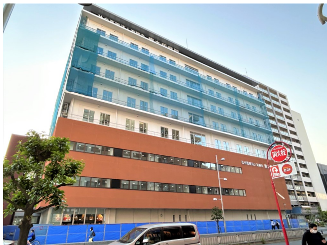
新病院 東側より
