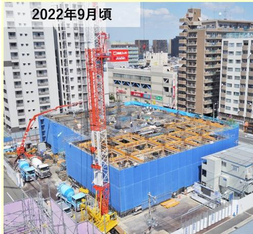
北側では、2階の天井・3階床にコンクリートを打設中。
